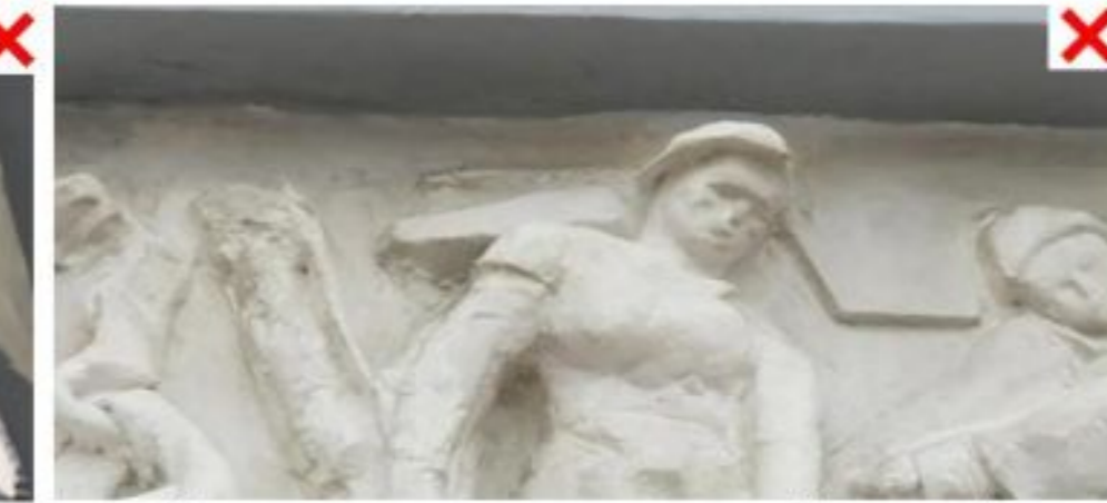
⊘ потеря пластики декора из-за многослойных окрашиваний и (или) окрашиваний без восполнения дефектов элементов декора
