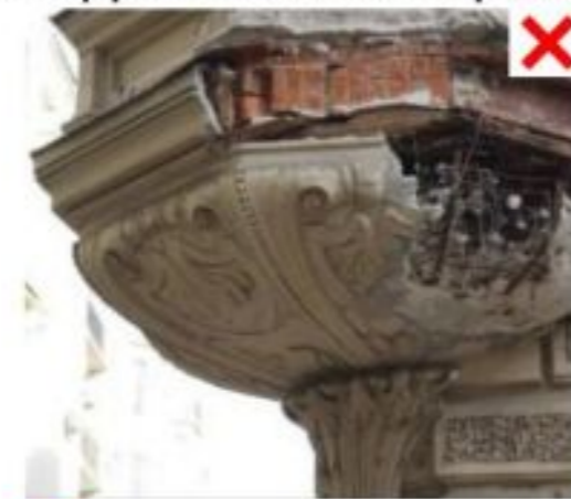
⊘ обнажение крепежных элементов
