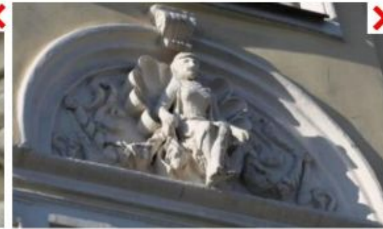
⊘ потеря пластики декора из-за многослойных окрашиваний и (или) окрашиваний без восполнения дефектов элементов декора
