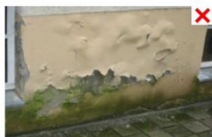
⊘ иные разрушения красочного слоя
